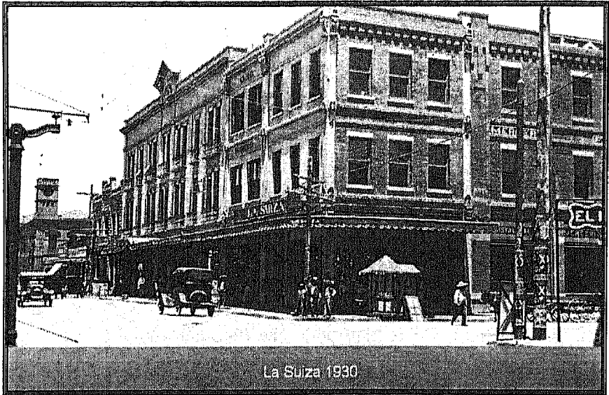
Av. Hidalgo en su cruce con calle Zaragoza.
